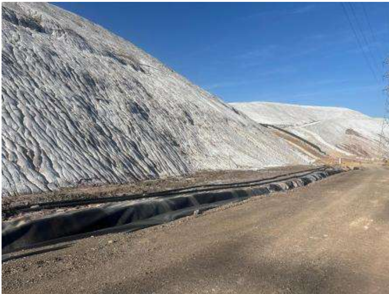
El Cogullo con su zanja perimetral para recoger los lixiviados salinos. Antonio Cerrillo
